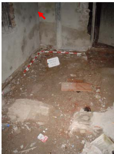
1. Estat inicial. Sector 100
