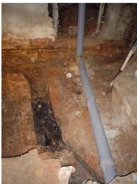
Tub de PVC un cop instal·lat
