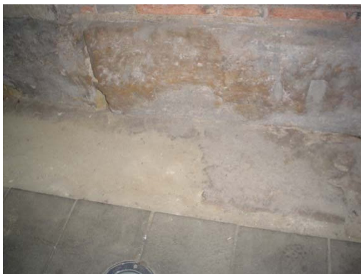
Detall del podi del temple i del nivell de circulació de la seva base
