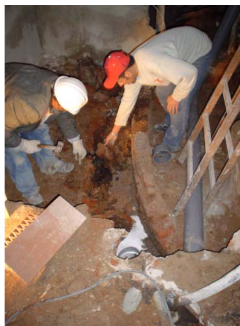
Treball de desmuntatge de les estructures
